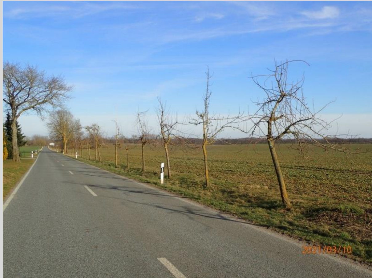
Kreisstraße VG 55: Jungpflanzung mit längerem Pflegebedarf (Lichtraumprofil, Erziehungsschnitte Obstbäume) (Boldekow in Richtung Putzier, Blick SO)
