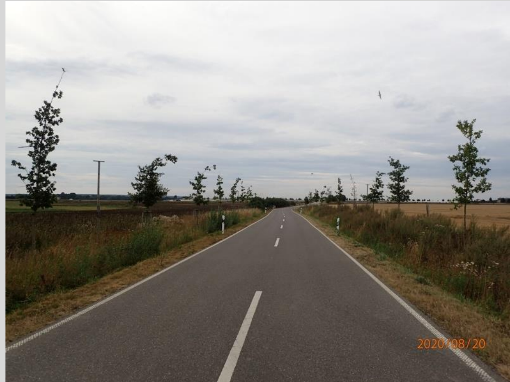
Kreisstraße VG 106: Pflege und Entwicklung Jungpflanzung zur vitalen Allee (Pritzenow in Richtung Daberkow)
