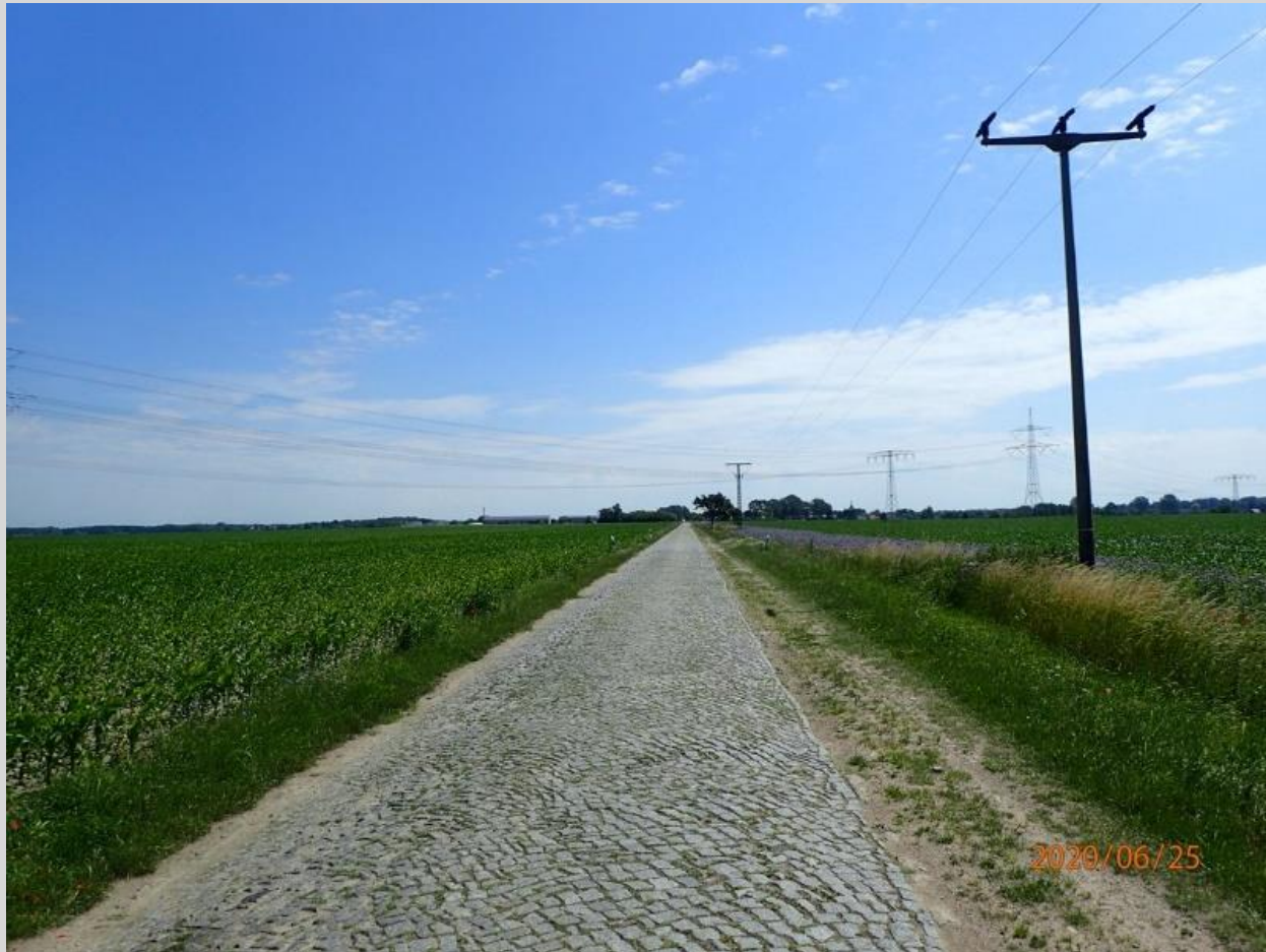
Kreisstraße VG 98: Baumfreier Abschnitt mit eingeschränkter Möglichkeit der Bepflanzung (Drosedow in Richtung Loitz)
