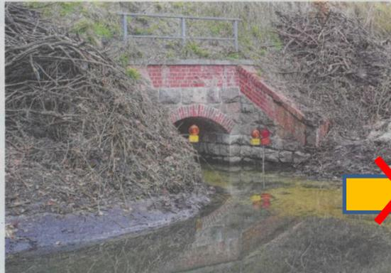
Diese Unterführung der Bahnstrecke zwischen Ramin und Plöwen hatte der Biber zugebaut. Das Wasser staute sich über zwei Meter hoch. Hält dieser Zustand längere Zeit an, besteht die Gefahr, dass der Bahndamm aufweicht.
